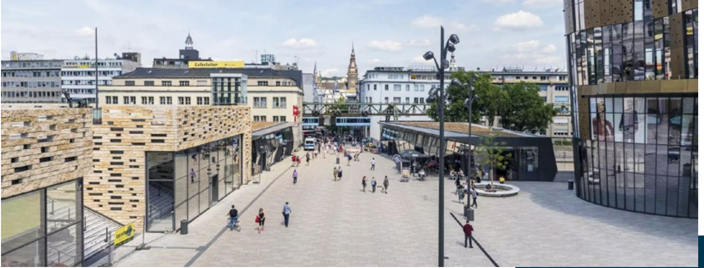
Blick vom Bahnhof auf den Döppersberg, das neue Eingangstor zur Elberfelder Innenstadt
